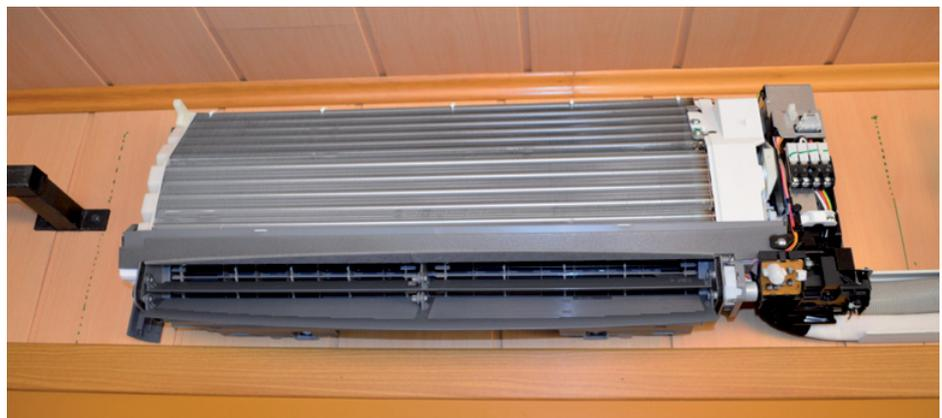
Schalltechnisch macht es einen großen Unterschied, ob z.B. das Innengerät einer Split-Klimaanlage an einer Wand, einer Ecke, oder einer Raumkante montiert ist.
